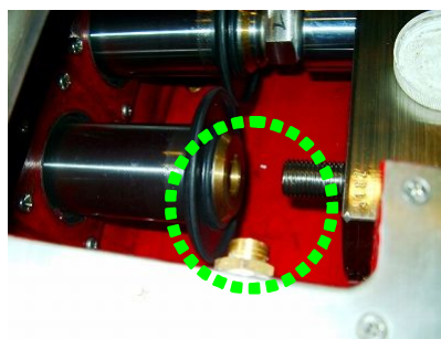
冷却水パイプを外して作業すると効率が上がります。
